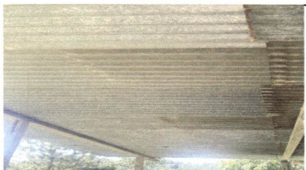
Foto 5: lamina en malas condiciones por corrosion.
