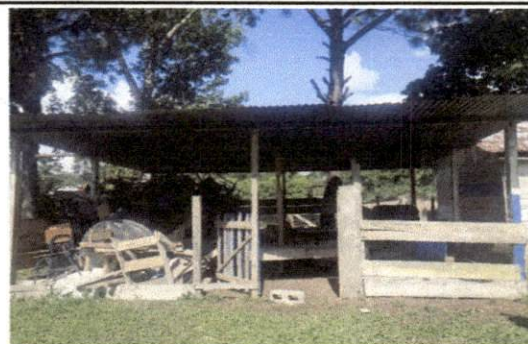
Foto 10: techo de cocina sin bajadas ni canal de agua.
