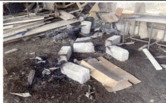
Foto 11: piso de cocina en malas condiciones por falta de torta de concreto.
